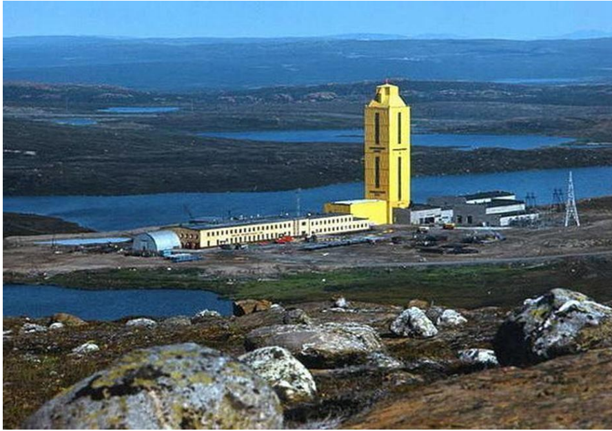
科拉超深井现场
